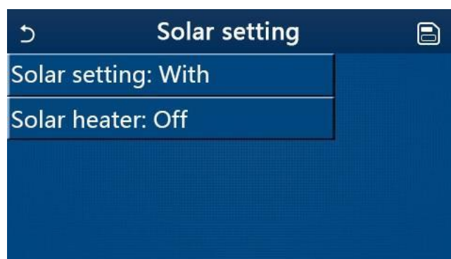
Solar setting (Solárny systém)
